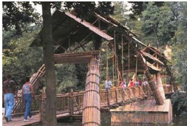
Imagem 03 - Ponte de Bambu em Stuttgart, na Alemanha
