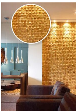
Imagem 08: Parede com revestimento de bambu Fonte: http://festaviva.uol.com.br/
