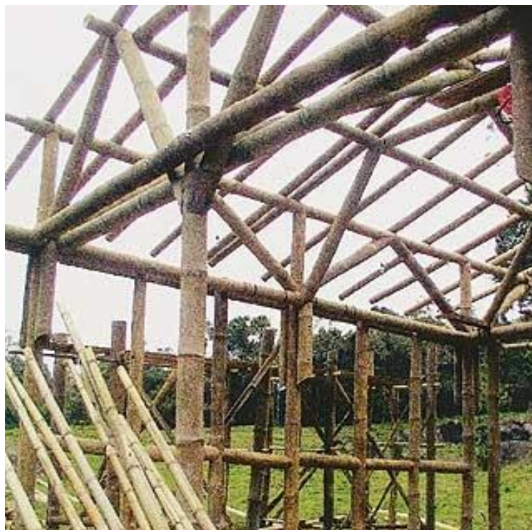
Imagem 05 – Estrutura feita com bambu
