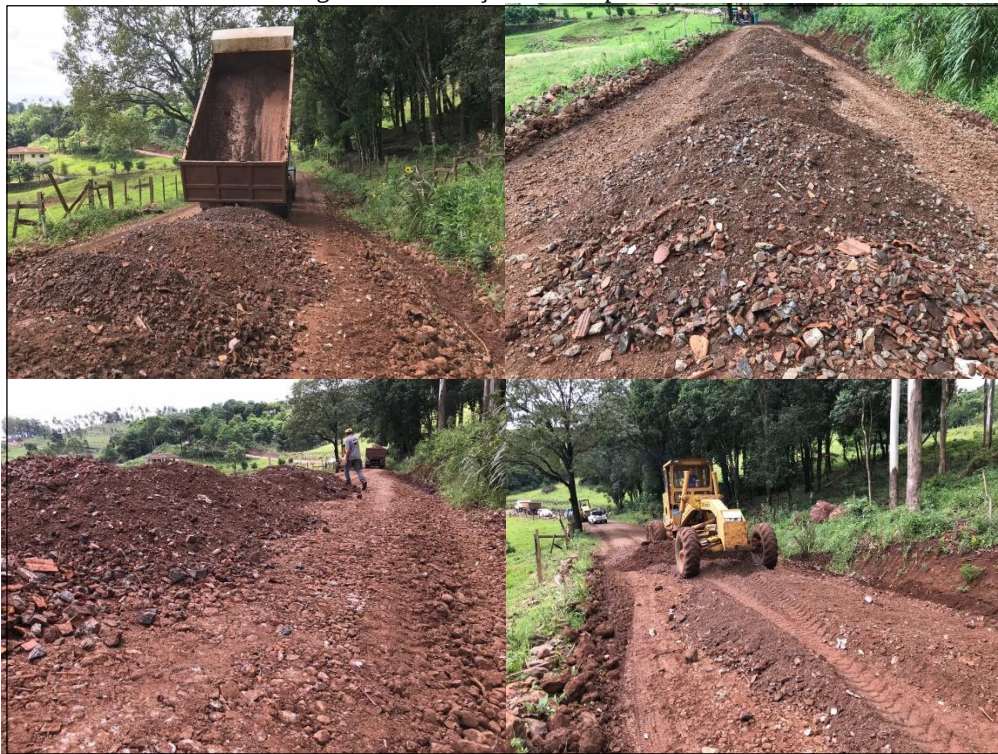
Figura 13: Execução do Campo de teste
